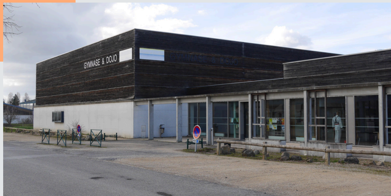
Extérieur du gymnase
